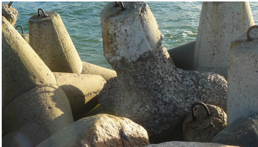
15.att. Tetrapods ar betona virsmas izdrupumiem.
