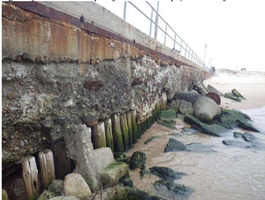
13.att. Betona izdrupums jūras pusē. Atsegti koka pāļi. 2+90. Tukšumi aiz pāļiem.
