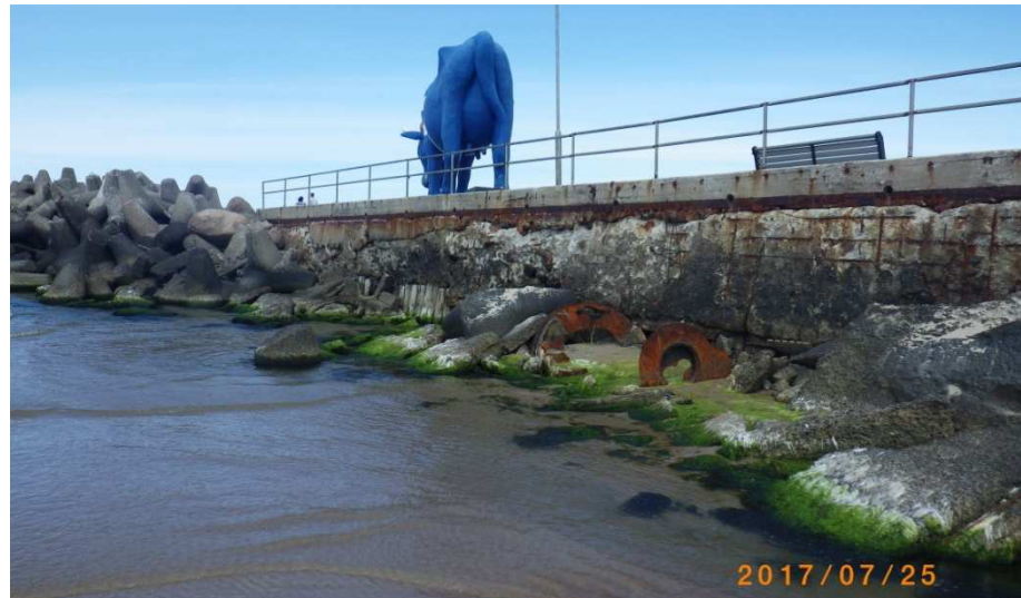
9.att. Mola betona virsbūve savienojuma vietā ar tetrapodu krāvēju.
