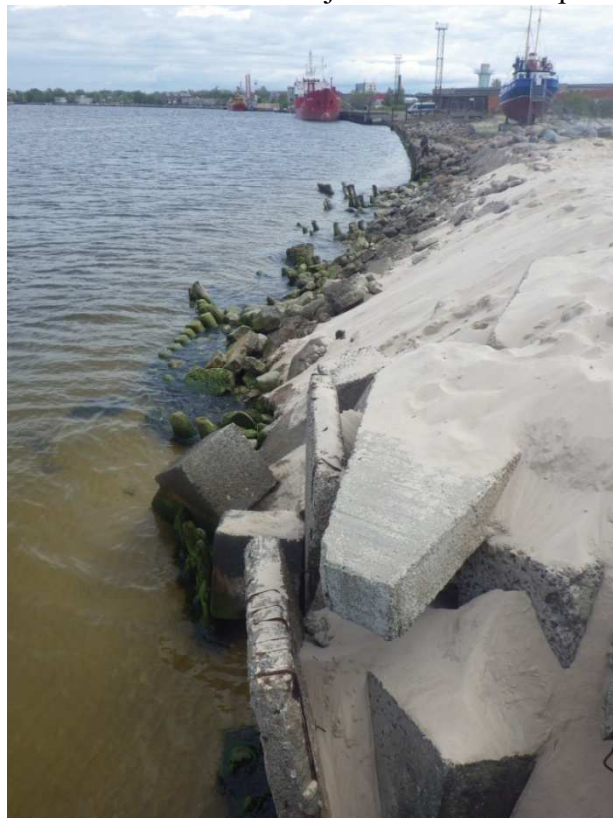
10.att. Zona, kur izveidojams nogāzes nostiprinājums ar laukakmeņiem.
