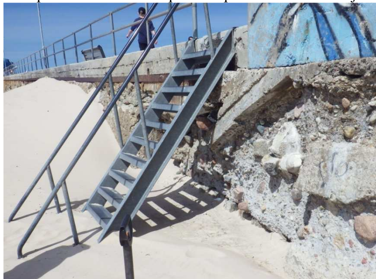
12.att. Esošām kāpnēm ir neatbilstošs pakāpienu slīpums. Esošo kāpņu vietā paredzētas jaunas.
