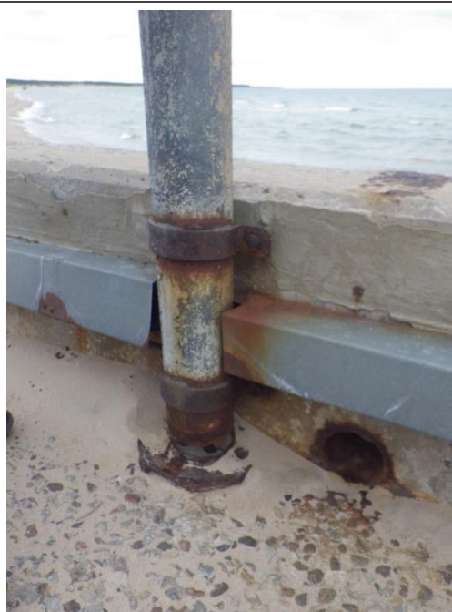
6. att. Korozijas bojājumi pie staba pamatnes.
