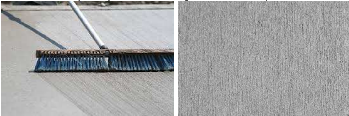
13.att. Betona virsmas apstrāde.
