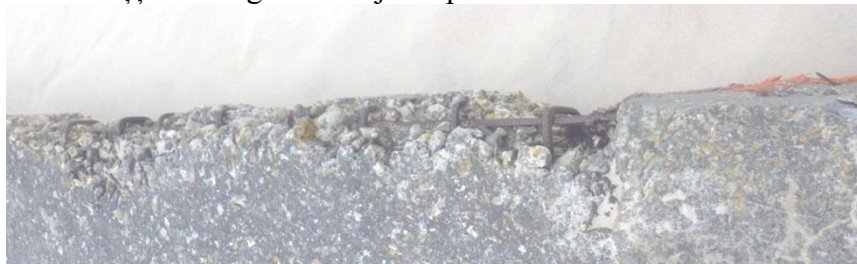
12.att. Nodrupis betons, korodē atsegts stiegrojums.
