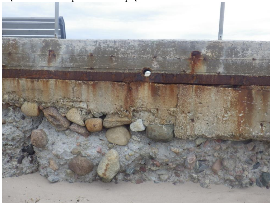
13.att. Betona izdrupums jūras pusē PK2+65.
